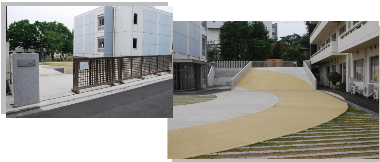
(1) 完成した中庭と新設のゲート
