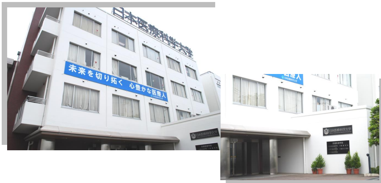
(2) 綺麗に塗装された1号棟壁面
